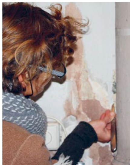
Die Vorbereitung der Innenrenovierung umfasst auch die Erfassung und Sicherung der historischen Bemalung. Restauratorin Frau Anja Stadler bei der Arbeit.
