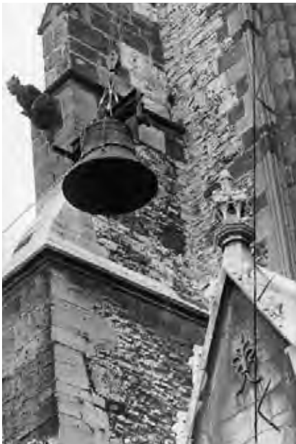
Die Jacobiglocke wird mit einem Flaschenzug in den Turm gehoben.
