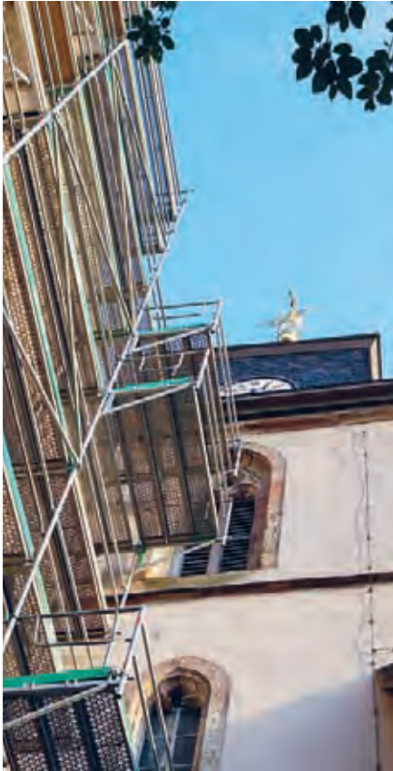
Dachstuhlsanierung in St. Marien
