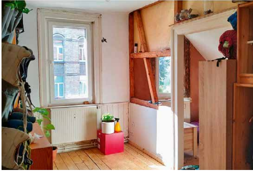
Viel Zeit und Arbeit steckt in der Sanierung des Grünen Hauses.
