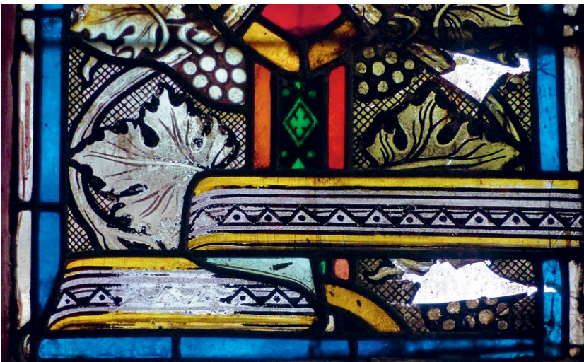
Evangelistenfenster: mit Klargläsern geflickte Fehlstellen einer früheren Reparatur. Sie werden bei der Restaurierung durch passgenaue Ergänzungsgläser ersetzt.
