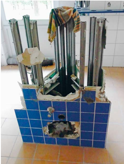
Abrissarbeiten im Bad des Kindergartens.
